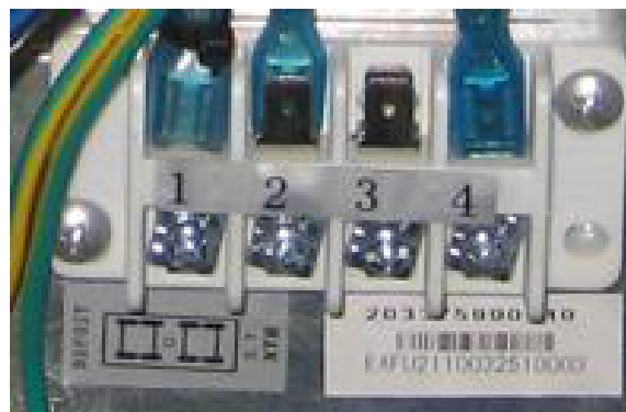
Рис. 12. Электроподключение компрессорно-конденсаторных блоков ACQ-45/3
